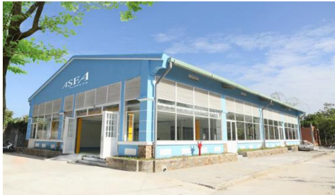
2019年1月11日ベトナムビンズオン省 にアスファ製造工場が完成致しました。
